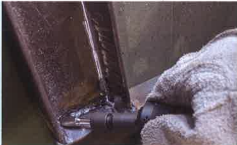
溶接部の ビード除去
